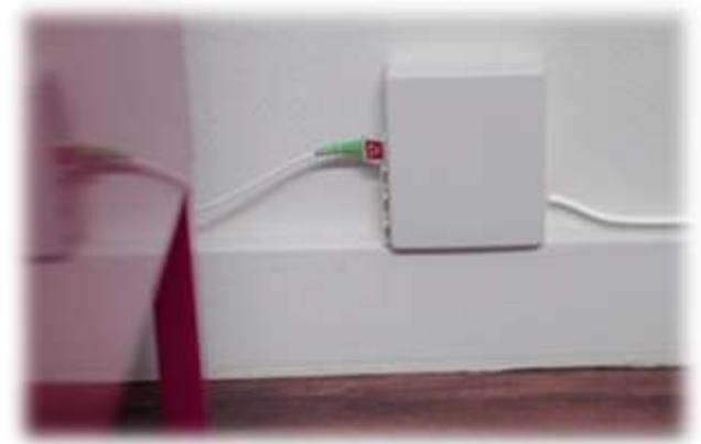
➤ **Le raccordement fibre optique entre le PBO et l'intérieur du logement utilise le même chemin que le câble téléphone existant (aérien, souterrain, etc.)**
